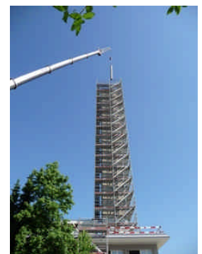
Einbringung neue Abgasleitung
