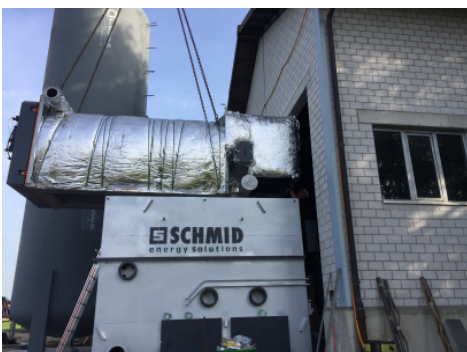
Einbringen 2'000 kW-Holzschnitzelkessel
