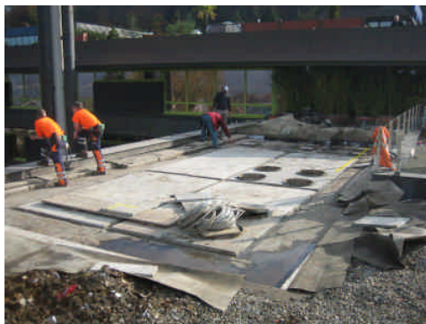
Dach bevor der Monoblock angefliegen wird
