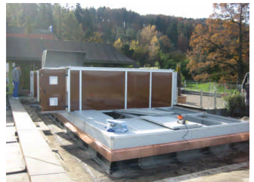
Der neue Monoblock auf dem Dach
