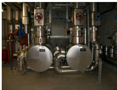
5 MW-RohrbündelWärmetauscher
