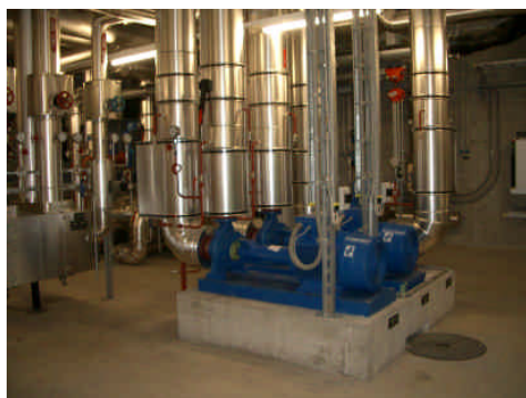
Hauptpumpen Fernleitung zu Dock Midfield
