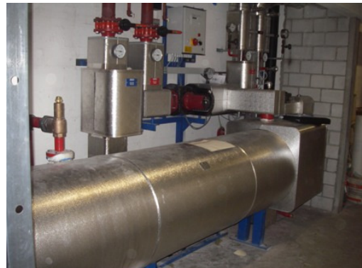
FW-Übergabestation mit Rohrbündelwärmetauscher
