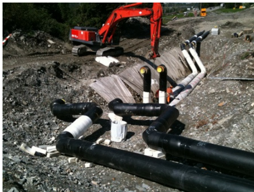
Fernleitung DN300, Unterfahren einer „Rüfe“
