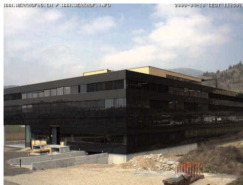
Aussenfassade vom mps Gebäude
