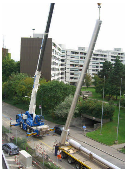
Anlieferung Abgasleitung DN450n
