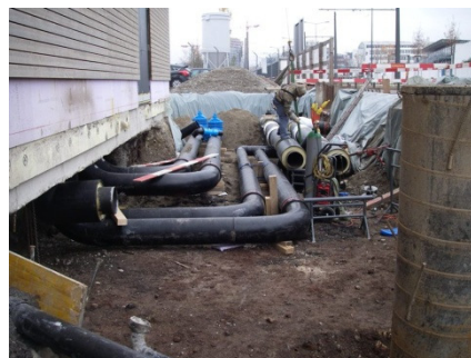
Hauseinführung Fernwärme-/Kälte
