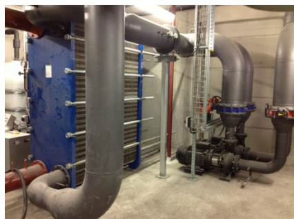
Rückkühlwärmetauscher 5.8MW
